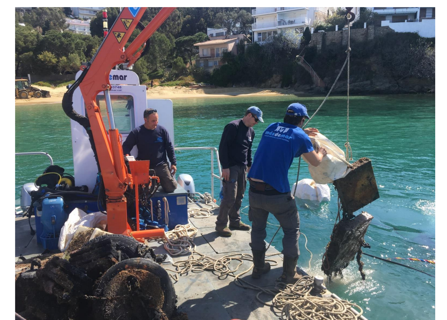
Figura 6: carga de los residuos extraídos a la embarcación, mediante el uso de la grúa.
