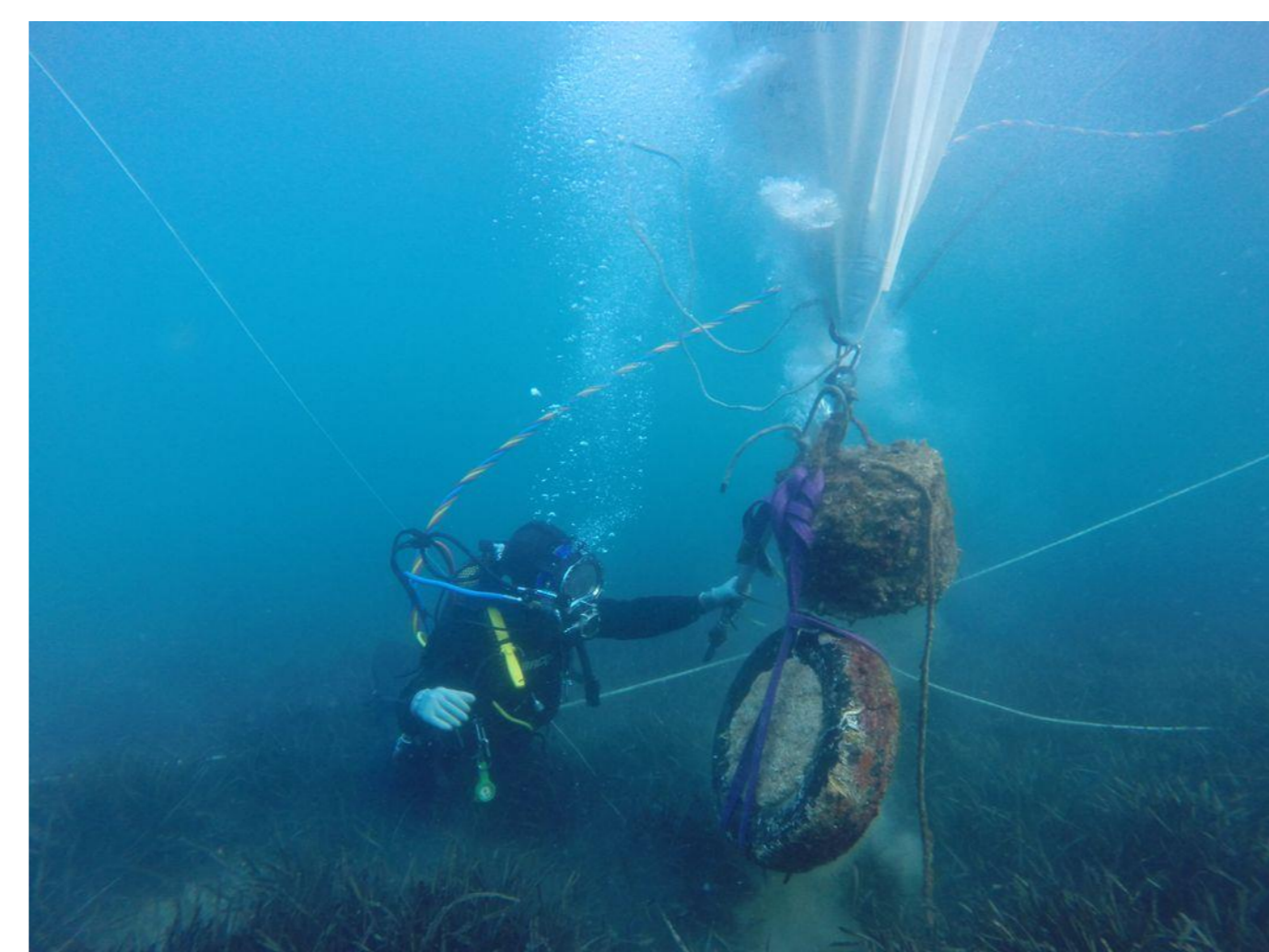
Figura 4: maniobra de izado de un muerto de fondeo mediante el uso de un globo elevador.
