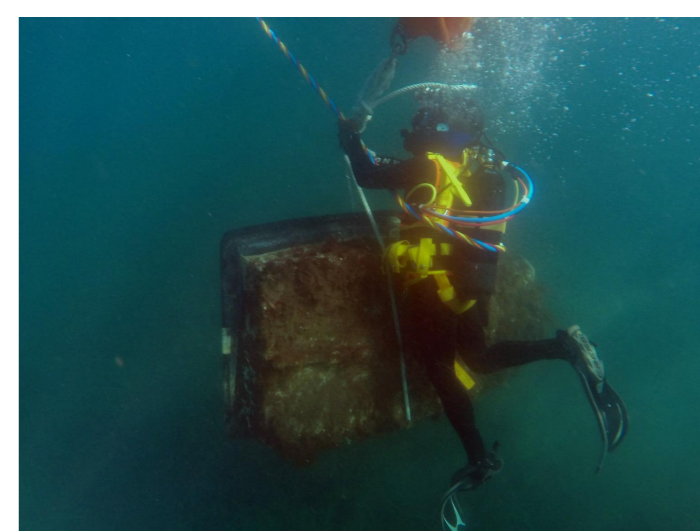
Figura 5: izado para la extracción de una embarcación hundida.
